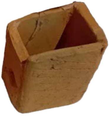
Typischer und gut erhaltener Hohlziegel (tubulus) einer römischen Wandheizung 140 x 110 x H300 mm
